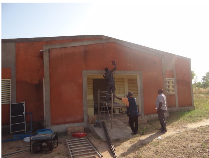
Die Techniker von MicroSow bei der Arbeit an der Krankenstation
