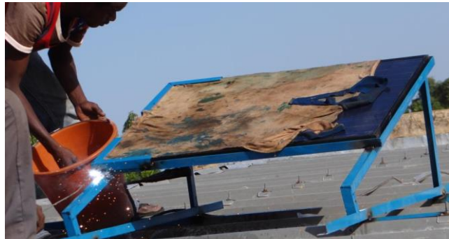
Beim Schweißen muss vorsichtig vorgegangen werden, damit das Photovoltaikmodul nicht beschädigt wird.
